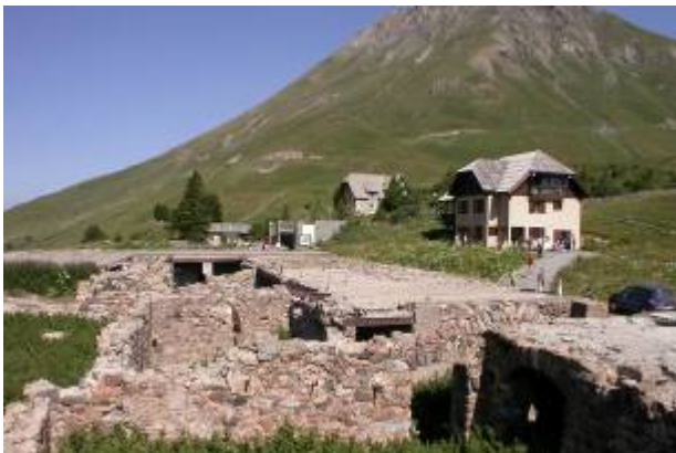
La ruine de l'hôtel PLM située à proximité des deux chalets actuels (Chalet-laboratoire et chalet Miranda)
